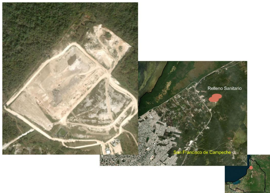
Figura 2. Relleno Sanitario de la ciudad de San Francisco de Campeche.
